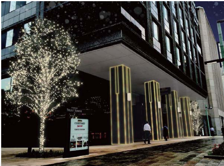
京橋トラストタワーイルミネーション（イメージ）
