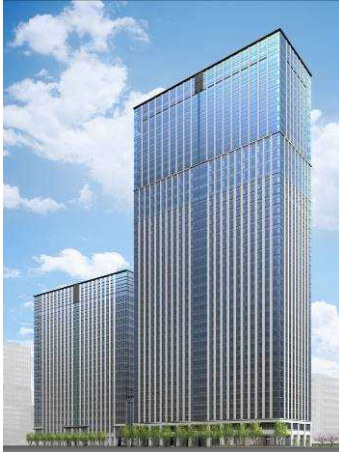
丸の内トラストタワー（本館・N館）
