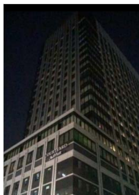
停電直後の外観
