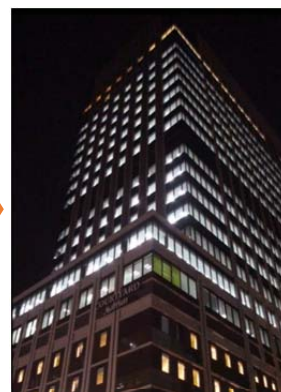
非常用発電機稼働中の外観
