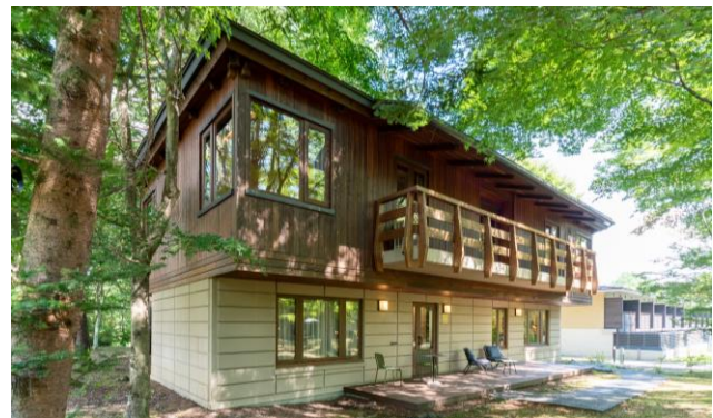
「Workation+ Cottage KARUIZAWA」
