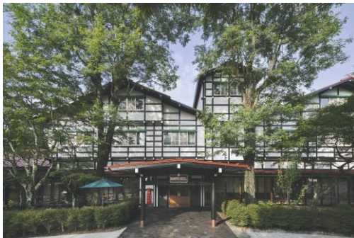
改修後 万平ホテル外観
