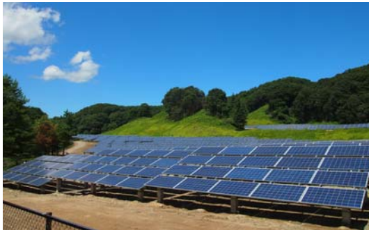
【第 1 期事業 施設写真】
