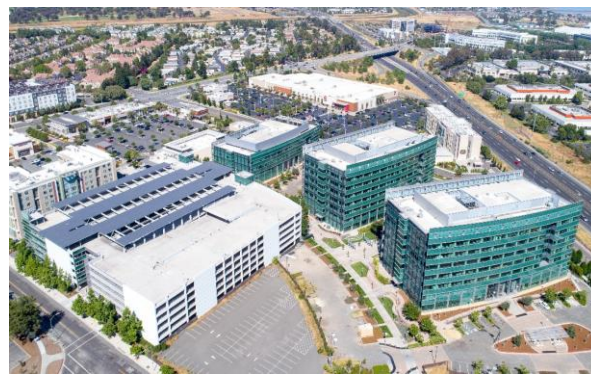
上空からの外観
