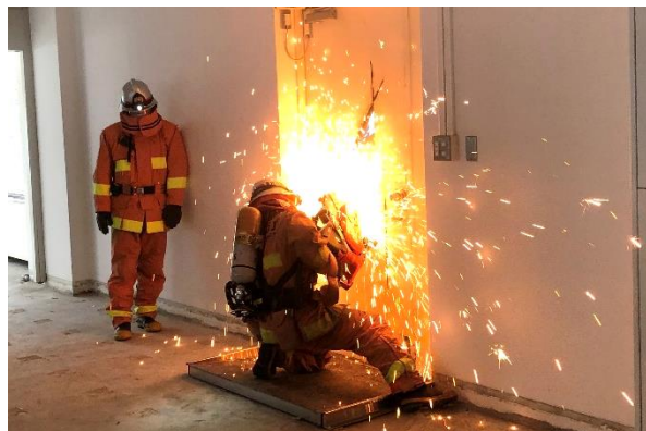
エンジンカッターによる防火戸破壊訓練の様子
