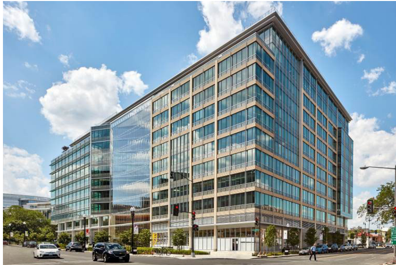
取得したオフィスビル 外観
